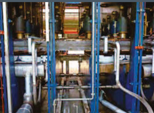
Angehobene Heizplatten mit eingelegeten Druckverteilterplatten
