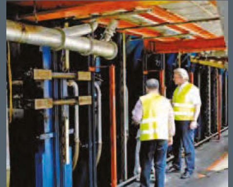
Inspektion der Umbauarbeiten durch Siempelkamp-Mitarbeiter
